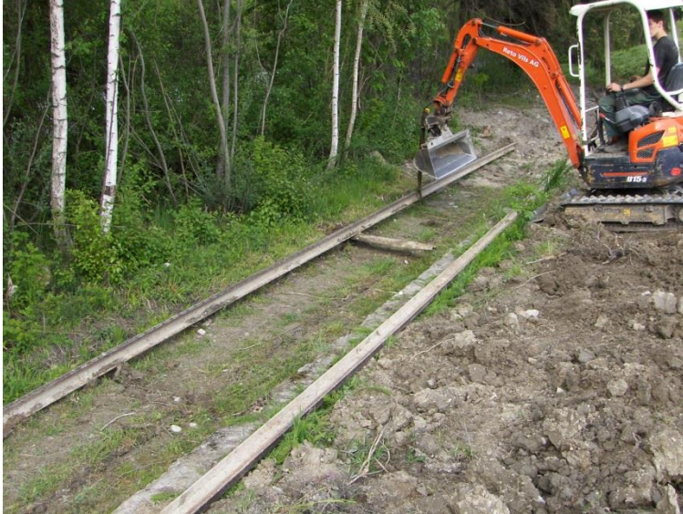
Abbruch der letzten 20 Meter Strecke Bild: Remo Hartmann
