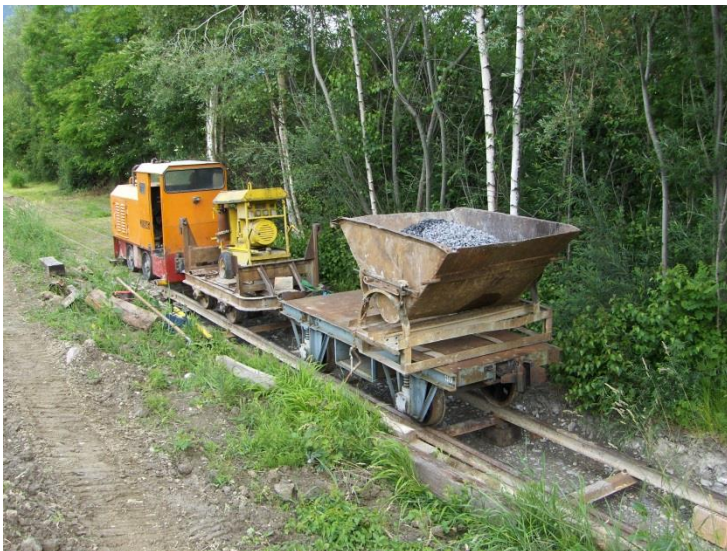
Unser Gleisbauzug auf der neu gebauten Strecke Bild: Remo Hartmann
