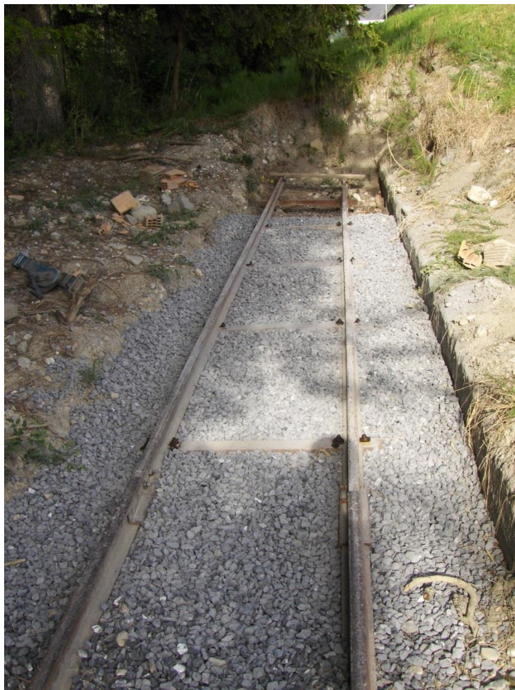
Das frisch geschotterte Gleis Bild: Remo Hartmann
